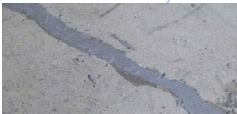
рис. 2. Смесь для ремонта трещин быть наполненным.
