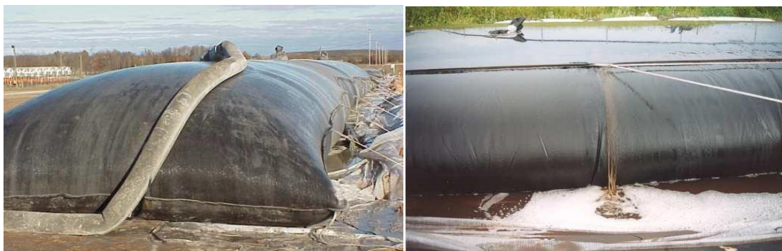
Рис. 4. Етапи «наповнення-зневоднення» за технологією Геотуб
